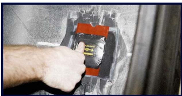
15. Középről kifelé haladva nyomkodja meg újjal a tapaszt.
