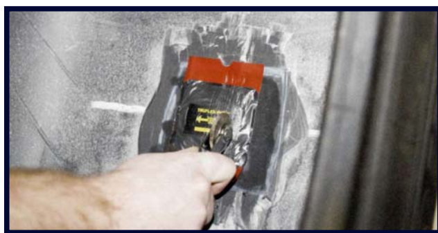
16. Miközben a piros fólia még mindig a fej szélén van, enyhe erővel, középről kifelé rádlizza le a fejet a felületre.
