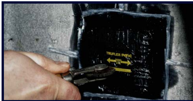
18. Lágyan az ellenkező irányban is rádlizza le a fejet, hogy a levegő maradéktalanul eltávozzon.
